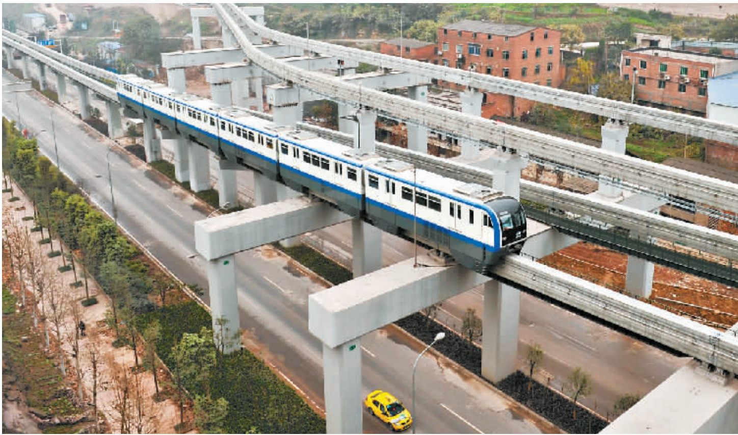
12月28日,一列跨座式单轨列车在依地形而建的轨道上快速运行。当日,随着重庆轨道交通3号线二塘至鱼洞段的开通试运行,全长55.5公里的轨道交通3号线正式实现全线贯通,这标志着全球最长的一条跨座式单轨交通线路在渝诞生。这条轨道交通线路南起鱼洞,北至重庆江北国际机场,横跨重庆主城区6区以及长江、嘉陵江两江,全程运行时间约90分钟,是贯穿重庆主城区南北方向的轨道交通大动脉。
