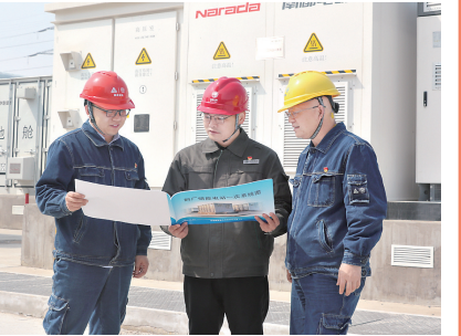
3月26日，国网鹤壁供电公司组织电力调度控制中心等人员到鹤淇电厂储能电站走访调研。 桑萍 摄
