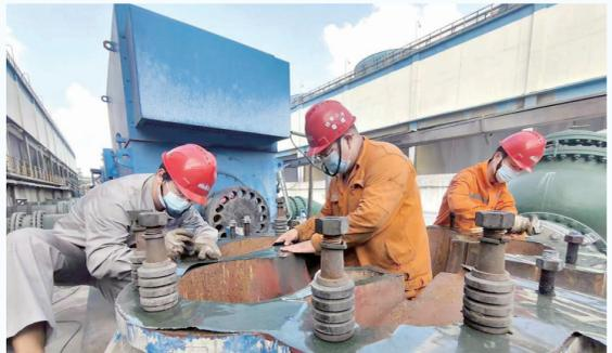
加强设备管理,降低生产成本。图为对冷却系统循环水泵检修。
