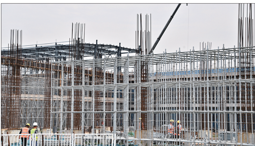
6月17日，占地面积170亩的航天食品产业园正在加快建设。
