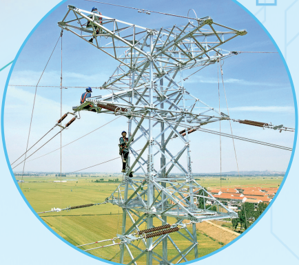
电力工程施工现场
