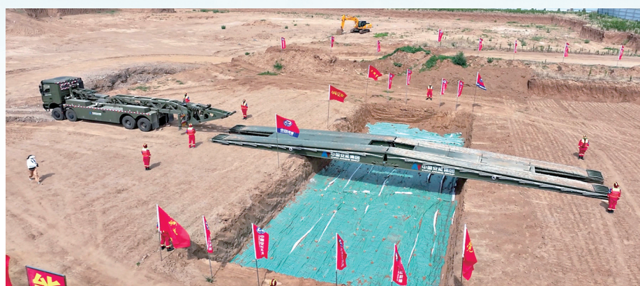
应急机械化桥搭建
