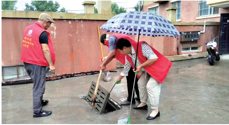
工作人员在清理排水管道中的杂物
