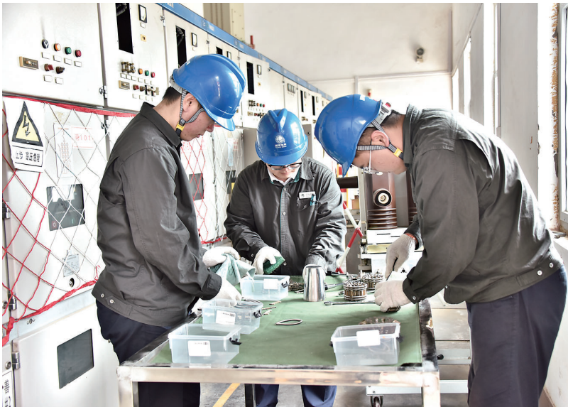
8月15日,2024年全市电力系统职工职业技能竞赛变电检修决赛在35千伏吉祥变电站举行,图为参赛选手在分解维修断路器梅花触头。
