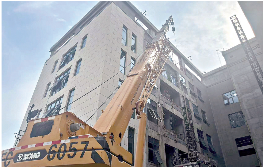
浚县人民医院提质升级项目施工现场
