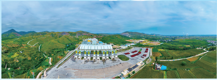
恒源矿业二道庄厂区全景
