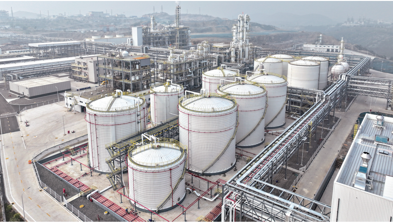
近期经过装置调试及投料试产,位于宝山经开区的美瑞聚氨酯新材料产业园一体化项目一期部分装置开车成功。该项目新材料产品将广泛应用于工业和汽车、高端医疗、特种装备等多个领域,助力我市高质量发展。 本报记者 卜仕豪 摄
