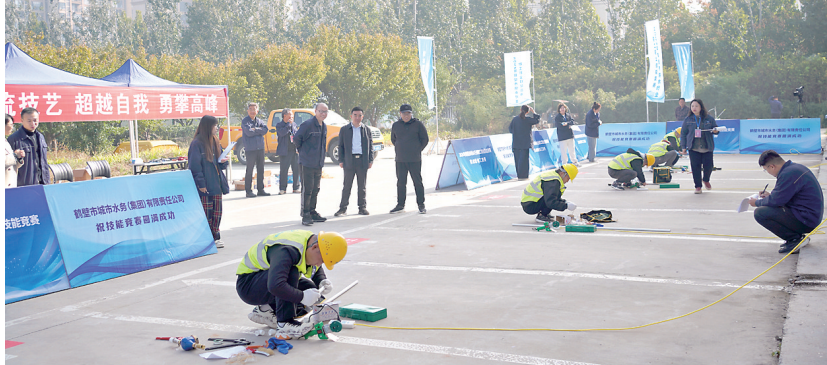
参赛选手进行供水管网及附属设施的加工与安装 鹤壁水务集团供图
