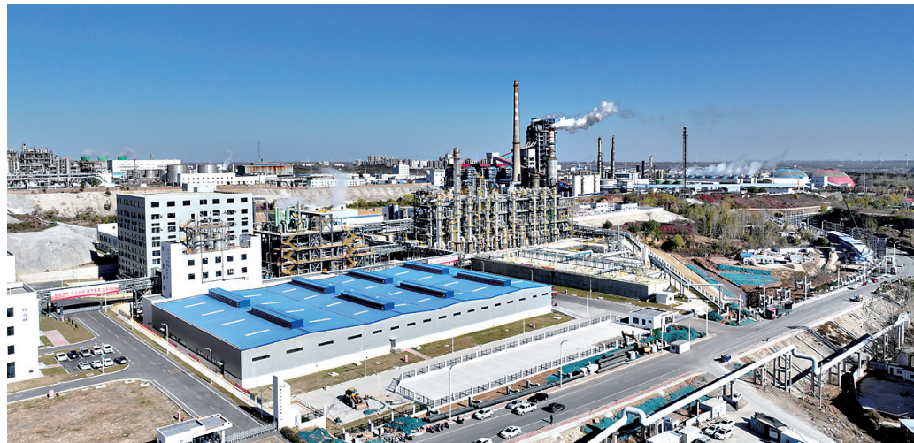
鹤壁龙宇新材料有限公司年产30万吨聚甲醛一期项目设计产能每年6万吨,拥有目前省内规模最大的单套生产装置。
