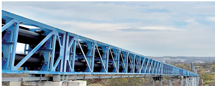
鹤淇电厂所需的煤通过管带输送机全封闭输送
