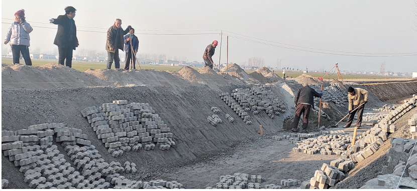
沟渠治理施工现场。 □本报记者 李丹丹 摄
