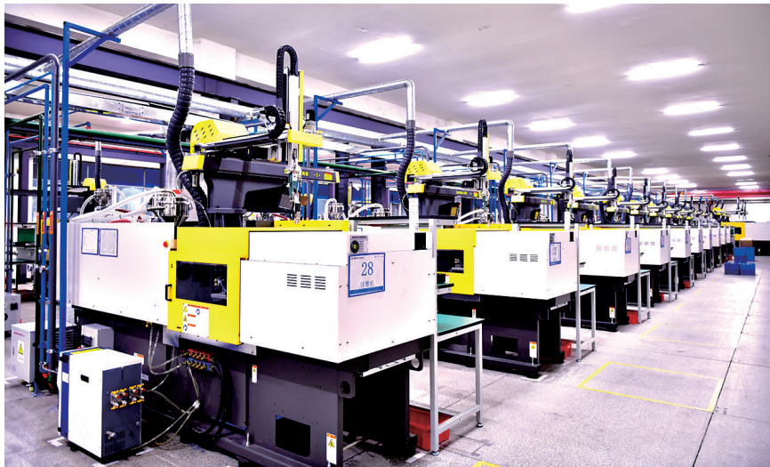
航瑞电子新能源汽车高压连接器项目通过产业整合、资源重组,向科技要效益,组建新型研发机构实现压铸类零配件的本地配套,管理和生产成本直降20%,综合效率提高50%。
