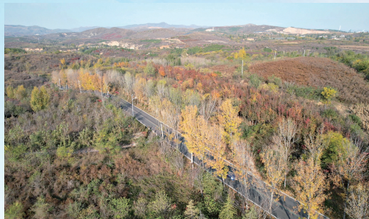
大海线淇滨区段廊道绿化工程
