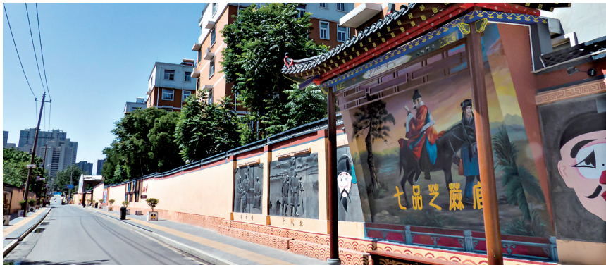
我市已完成对91条背街小巷的整治提升工作。图为戏曲小巷。 市城市管理局供图
