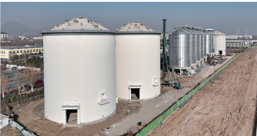
淇县粮食仓储、贸易及应急物资仓储和物流配送园区项目3、4号浅圆仓和部分立筒仓。
