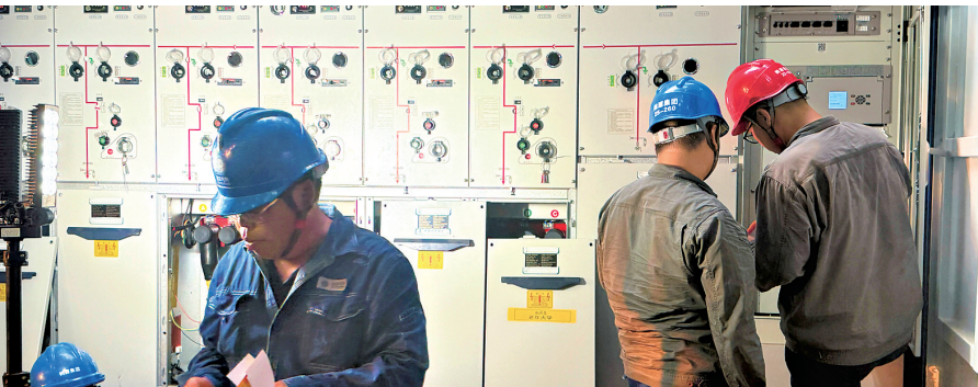
7月15日8时，鹤源集团电力施工人员经过连夜奋战，顺利完成10千伏珠14漓江路1号环网柜改造工作。此次改造不仅实现了新老设备更替，提升了电网供电可靠性，更推动了淇滨区新型智能配电网建设迈上新台阶——通过配置配网自愈系统（具备自动故障定位、隔离及非故障区恢复供电功能的智能系统），实现用户停电“零感知”目标，为辖区用户提供可靠的用电保障。 张宸铭、朱磊摄影报道
