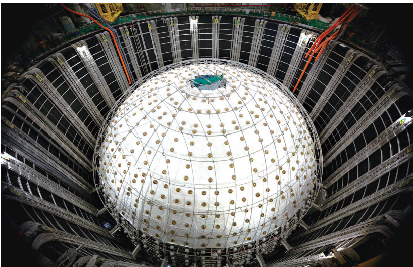
8月26日,江门中微子实验(JUNO)成功完成2万吨液体闪烁体灌注,并正式运行取数。经过十余年准备和建设,江门中微子实验成为国际上首个运行的超大规模和超高精度中微子专用大科学装置。 新华社记者 金立旺 摄
