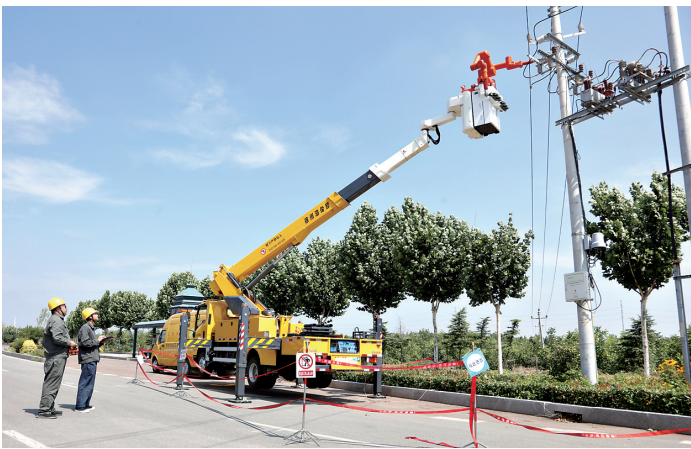
6月24日,国网鹤壁供电公司带电作业人员使用双臂带电作业机器人,为10千伏大中线西七里铺支线002号杆安装驱鸟器等附件。
