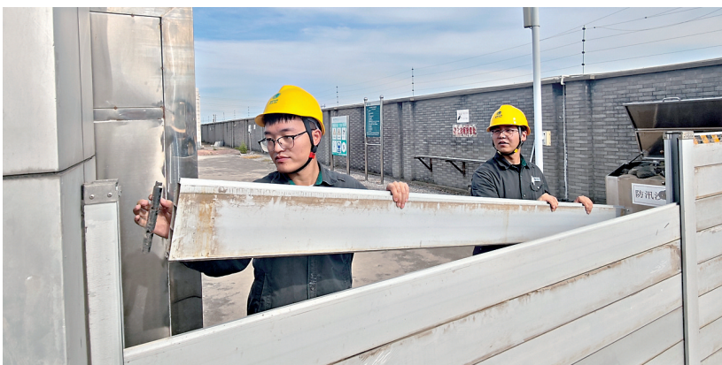
8月10日，220千伏展光变电站内，国网鹤壁供电公司变电运维中心工作人员正在提前安装防汛挡板，做好强降雨应对准备。桑萍 摄
