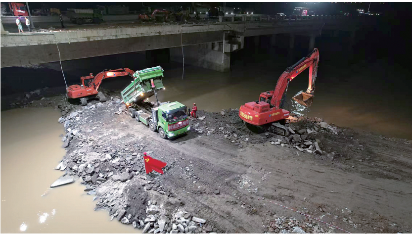
鹤壁救援基地队员在封堵溃口
