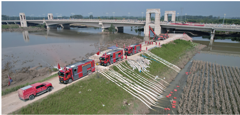
鹤壁救援基地大功率抽排水车在抽水。
